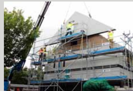
Het laatste geveldeel komt op zijn plek
